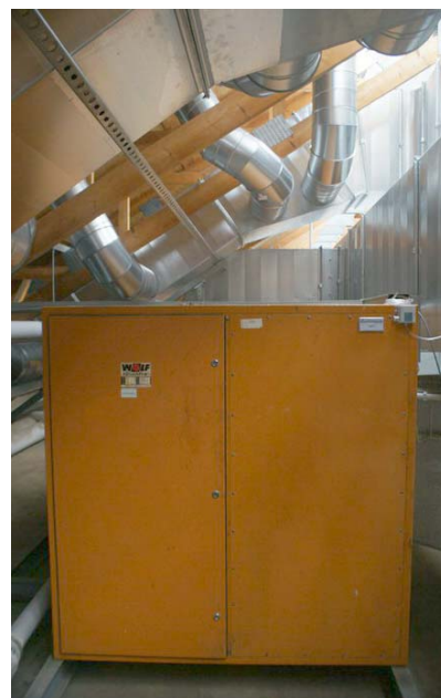
Lüftungsgerät KG 250
